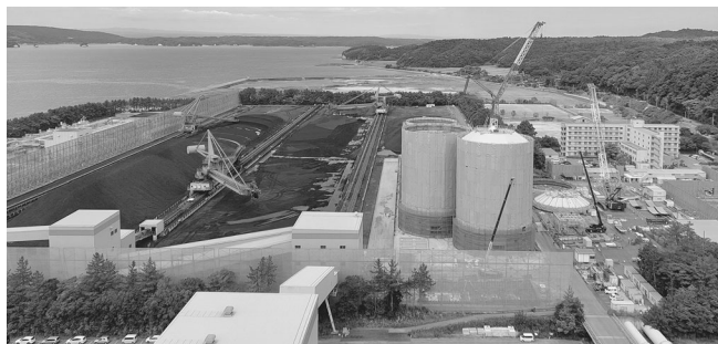
建設現場風景
